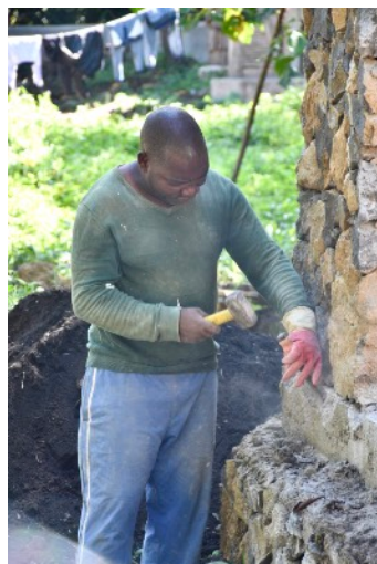
Abb. 11: Abspitzen der Fundamentreste beim Hauptgebäude.
