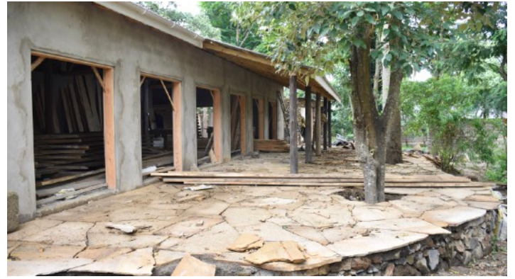
Abb. 2: Im Bau stehendes Hauptgebäude mit Veranda.
