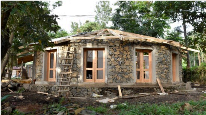
Abb. 1: Bedachung eines Schulraumes.
