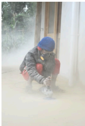
Abb. 9: Schleifen der Natursteinböden.
