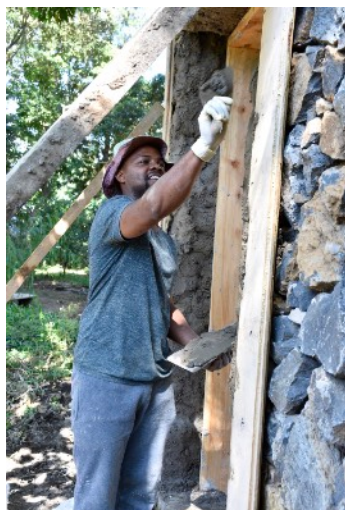
Abb. 10: Abschlussarbeiten der Fenster- und Türrahmen bei den Schulräumen.
