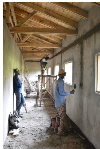
Abb. 12: Verputzen nach dem Verlegen der Stromleitungen in der Küche des Hauptgebäudes.
