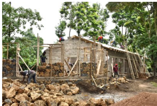
Abb. 6 - 8: Bauarbeiten am Hauptgebäude. Vom Giessen des Fundaments (oben) bis hin zum Errichten der Natursteinmauern (unten links) und dem Bedachen des Ess- und Aufenthaltsbereichs (unten rechts).
