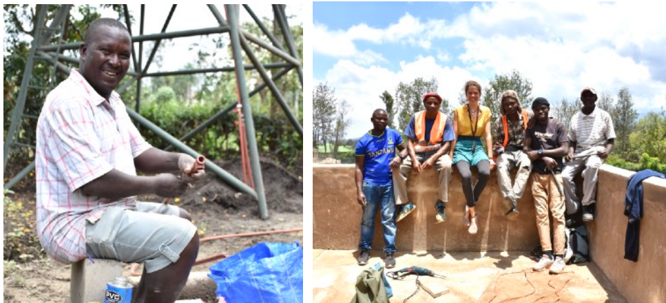
Abb. 13 & 14: Polier und Sanitär Bablo bei der Arbeit (links). Einen Teil des Dachdecker-Teams gemeinsam mit der Bauleiterin auf der Veranda des Wohngebäudes (rechts).
