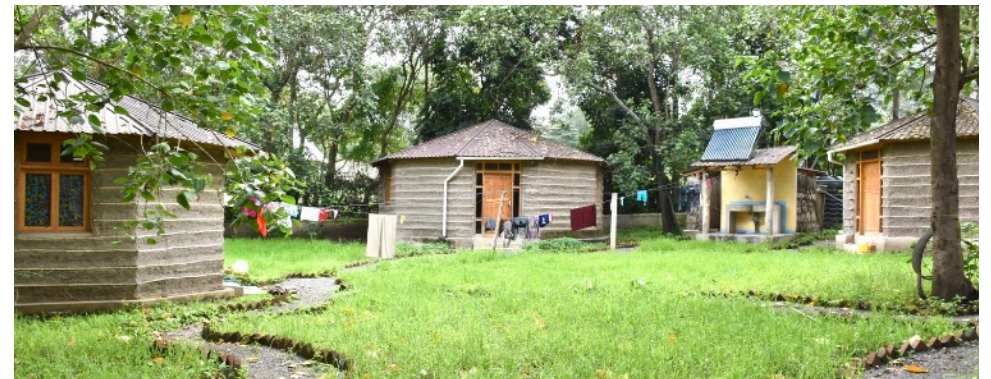
Abb. 8: Wohngebäude der Schülerinnen mit fertig angelegtem Weg und angepflanztem Rasen. Mit-tig rechts das Duschhäuschen mit Wärmeaufbereitungsanlage auf dem Vordach.
