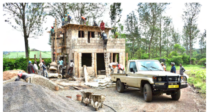
Abb. 2: Das im Bau stehende Bürogebäude.
