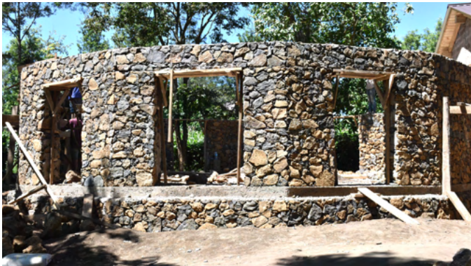
Abb. 3: Natursteinmauer eines Schulraums.
