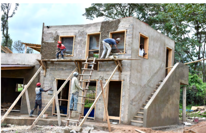
Abb. 1: Verputzen des Wohnhauses.
