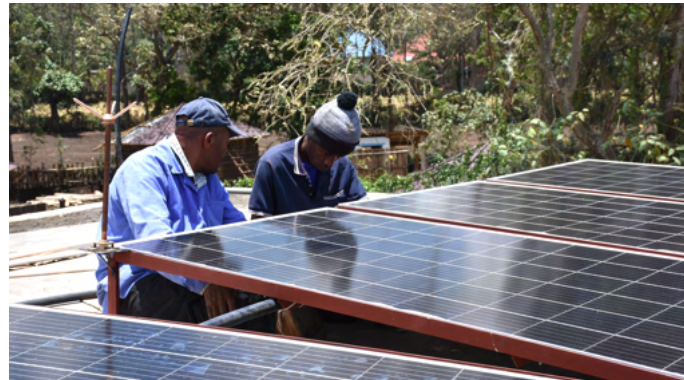
Abb.5: Installation der Solarpanels auf dem Wohngebäude.
