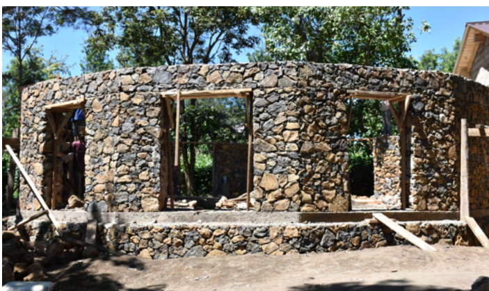
Abb. 5 links oben: Das im Bau stehende Hauptgebäude. Hinten wird gerade die Küche mit Essbereich und Lounge überdacht. Vorne beginnen die Arbeiter mit dem Naturmauerwerk eines Schulraums.
