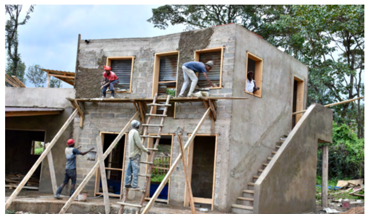
Abb. 5 links oben: Das im Bau stehende Hauptgebäude. Hinten wird gerade die Küche mit Essbereich und Lounge überdacht. Vorne beginnen die Arbeiter mit dem Naturmauerwerk eines Schulraums.
