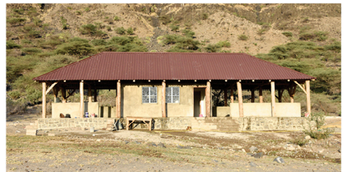
Abb. 2: Unser Projekthaus kurz vor Bauende am 2. Oktober 2021
