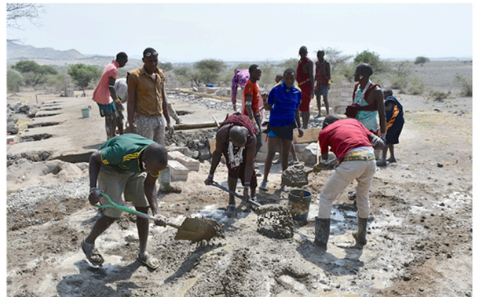
Abb. 14: Mischen des Zement-Mörtels
