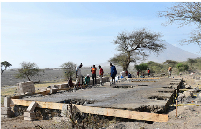
Abb. 13: Übergießen des Fundaments mit Zement-Mörtel
