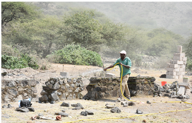
Abb. 9: Errichten der Natursteinmauer
