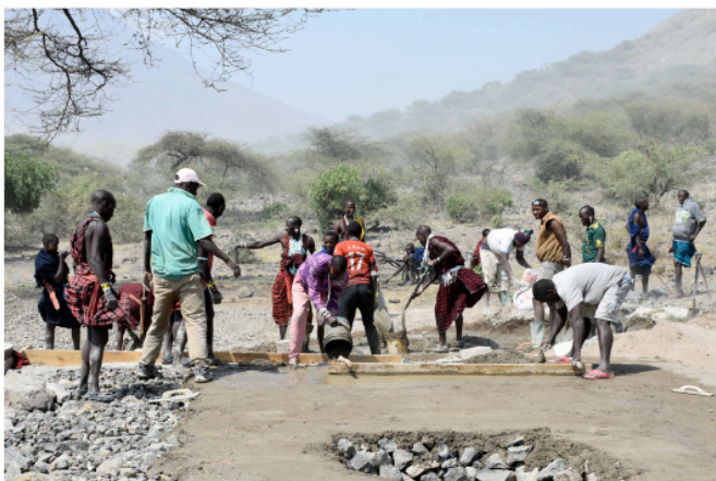
Abb. 3: Fundamentabschluss mit Zementüberguss
