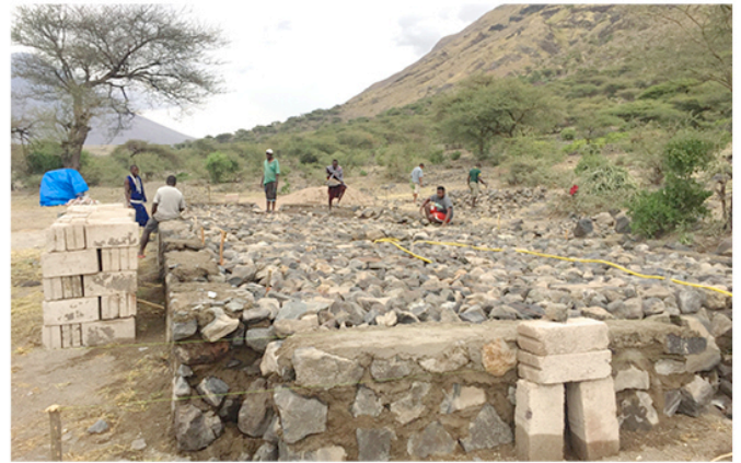
Abb. 12: Auffüllen des Fundaments mit Steinen
