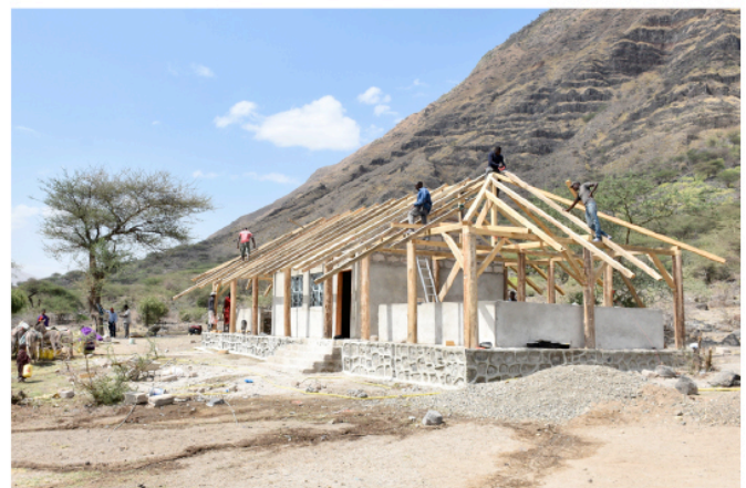
Abb. 4: Bau der Dachkonstruktion
