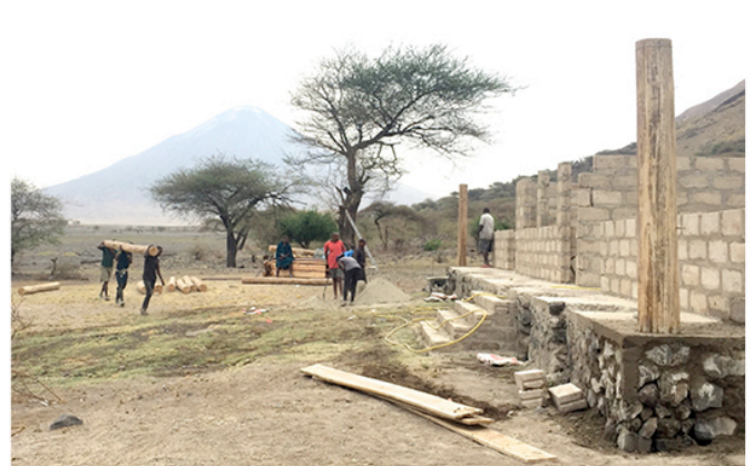
Abb. 16: Versenken der Holzstützen
