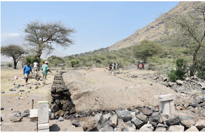
Abb. 11: Auffüllen des Fundaments mit Sand
