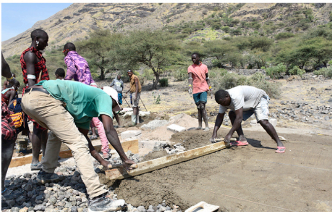
Abb. 15: Glattstreichen des Zement-Mörtels
